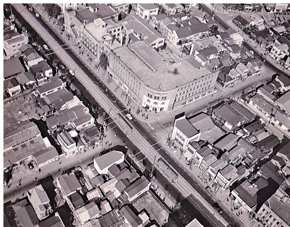
航空写真・水道橋（昭和20年代）中央が本学経済学部校舎
